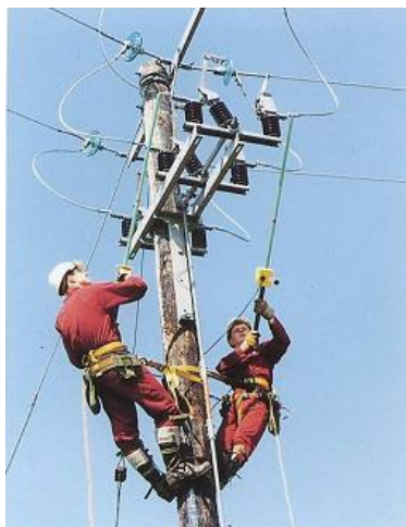
Testowanie linii napowietrznej
