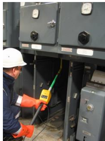
Testowanie w rozdzielnicy
